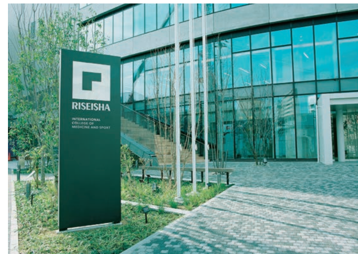
高さ3mの立看板が、校舎入口の目印
